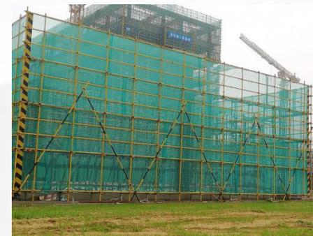
外挂式脚手架是产业化建筑施工时必须使用的重要工具之一，是为了保证高处作业人员安全、顺利进行施工而搭设的操作平台及防护。较传统脚手架安全性能更高，更经济实用。
